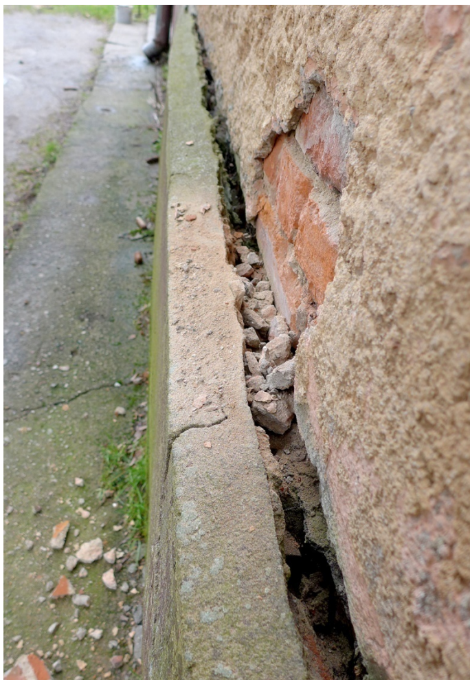
Fot. 13. Dębowiec 4, elewacja południowa, widoczne odspojenie ciężkiego betonowego cokołu. Odspojenie wystąpiło poprzez degradację cegły spowodowaną zbyt mocną zaprawą wierzchnią. Zaprawa betonowa odspaja się wraz z ceglanym licem.
