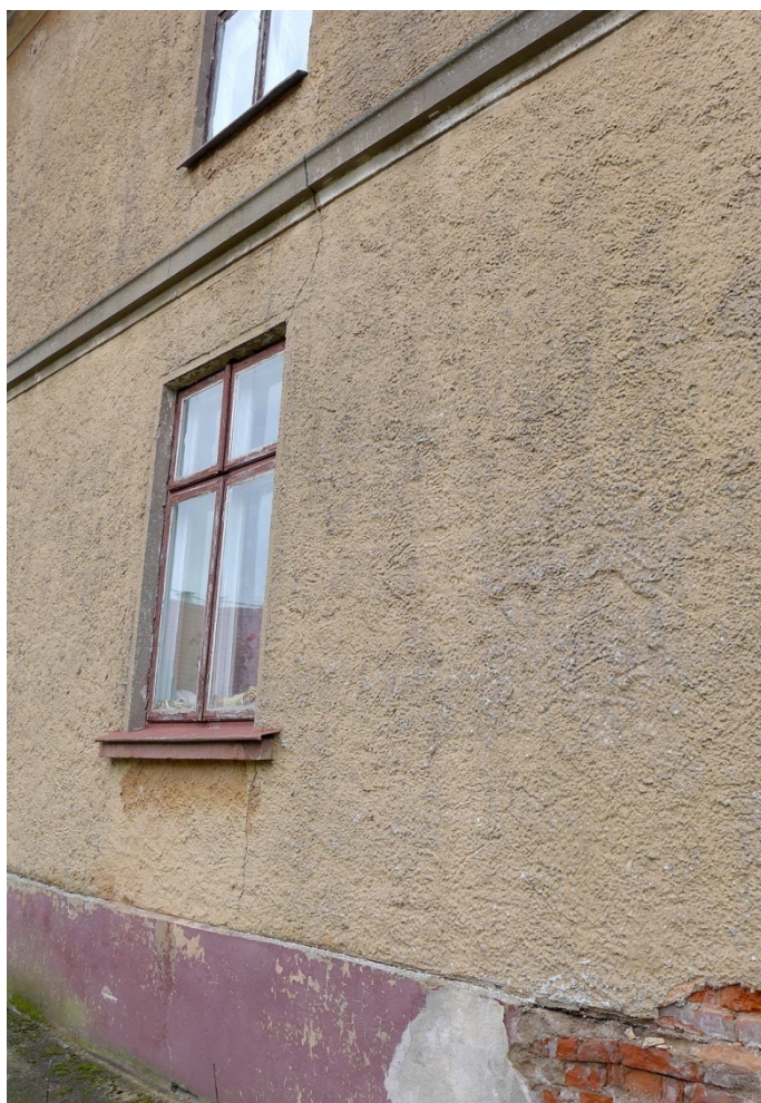
Fot. 20. Dębowiec 4, elewacja zachodnia, widoczne spękania strukturalne muru biegnące od cokołu do I piętra.
