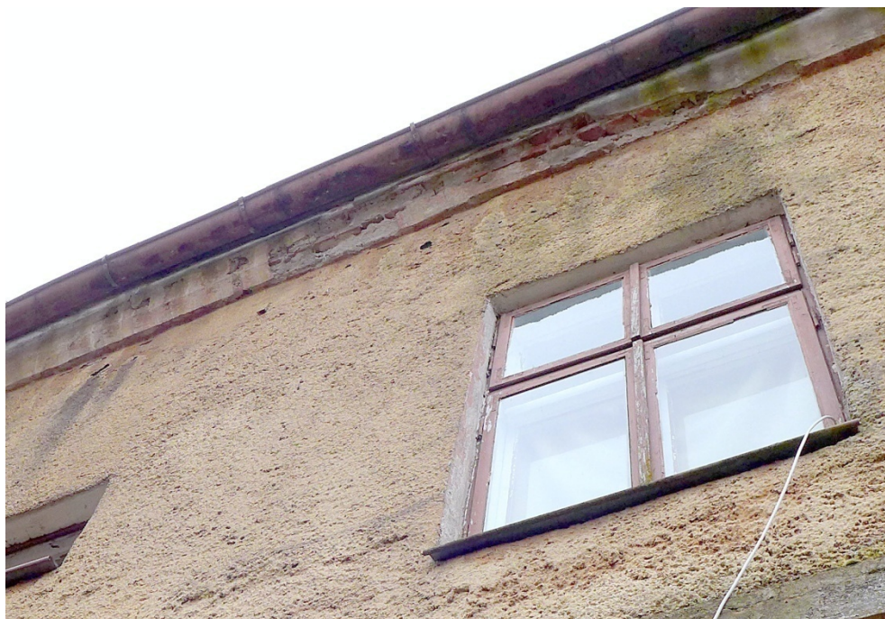
Fot. 5. Dębowiec 4, elewacja zachodnia, widoczne ubytki gzymsu kordonowego oraz przedziewiałe rynny.
