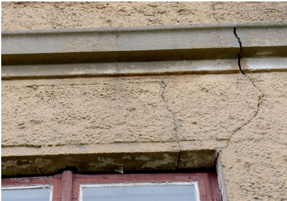
Fot. 9. Dębowiec 4, elewacja zachodnia, widoczne groźne spękanie strukturalne muru biegnące od narożnika okna przez gzyms kordonowy.
