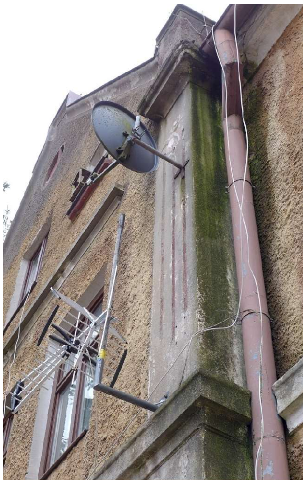
Fot. 15. Dębowiec 4, elewacja zachodnia, widoczne silne zawilgocenie w narożniku ryzalitu, spowodowane złym odprowadzeniem wody opadowej. Dodatkowo narożnik znacznie porażony biologicznie.
