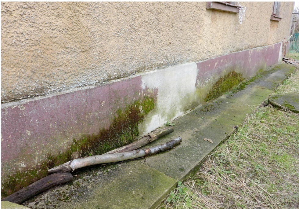
Fot. 7. Dębowiec 4, elewacja zachodnia, widoczny zawilgocony cokół porośnięty wykwitami mikroorganizmów i cała zielona opaska.
