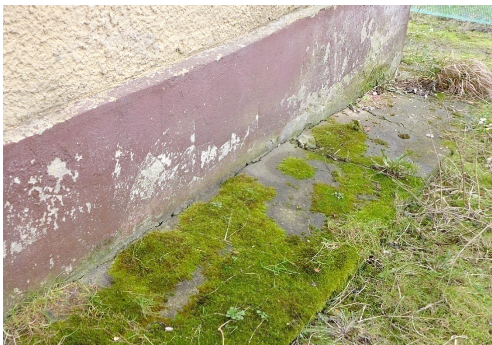
Fot. 6. Dębowiec 4, elewacja zachodnia, widoczna zawilgocona opaska betonowa wokół budynku, na powierzchni której bujnie rozwijają się mikroorganizmy. Opaska utrzymuje wilgoć pod powierzchnią, która nie ma gdzie odparować i wchodzi w mur.
