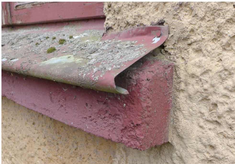
Fot. 3. Dębowiec 4, elewacja północna, zbliżenie pokazuje niepoprawny montaż metalowych parapetów, woda opadowa wcieka za blachę.
