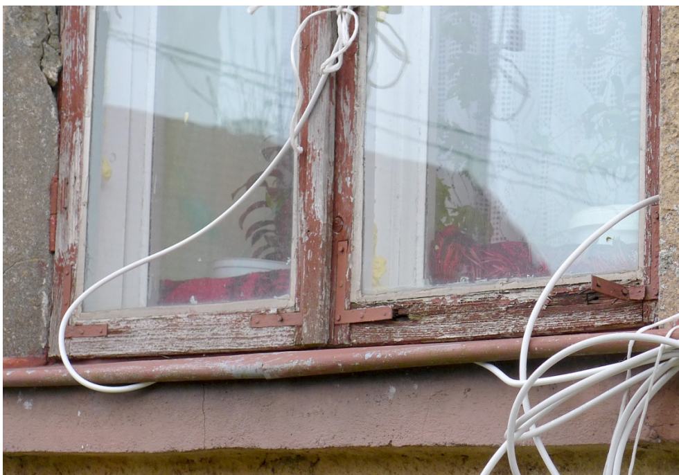
Fot. 8. Dębowiec 4, elewacja zachodnia, widoczny zły stan zachowania stolarki okiennej. Skrzydła mocno wypłukane, okucia skorodowane i poluzowane.
