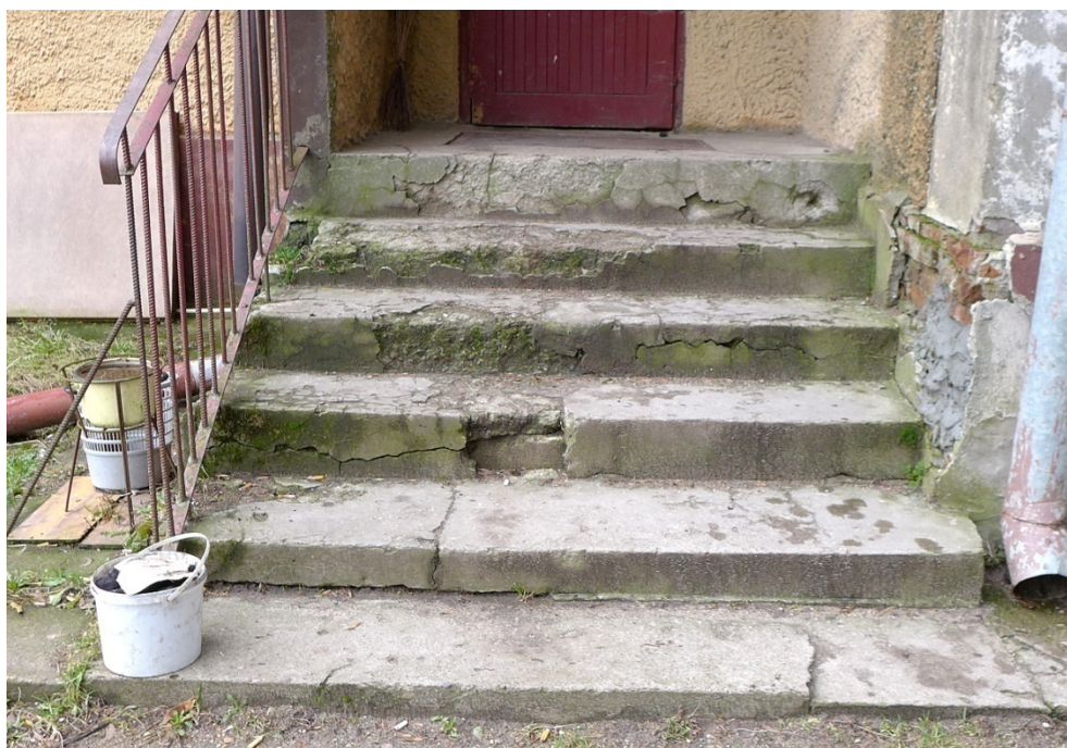
Fot. 18. Dębowiec 4, elewacja południowa, schody dyferencyjne, widoczny bardzo zły stan zachowania. Wylewka zawilgocona, spękana, pokryta wykwitami biologicznymi.
