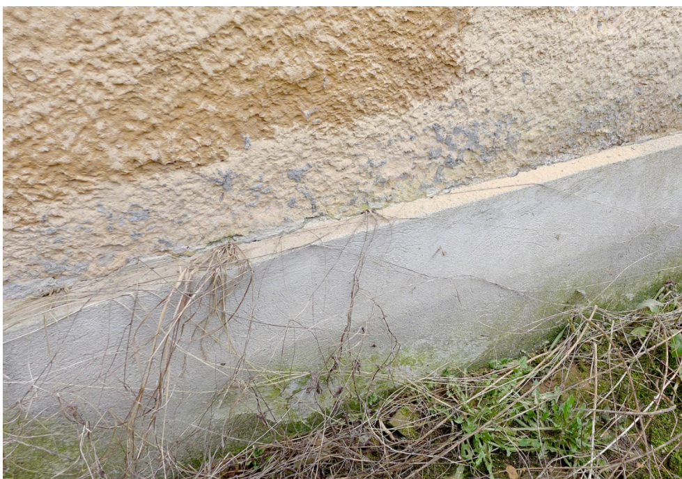
Fot. 2. Dębowiec 4, elewacja północna, widoczna roślinność wyrastająca w spękaniach między cokołem, a tłem elewacji. Cokół pokryty także mchami.
