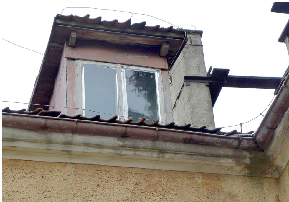
Fot. 19. Dębowiec 4, elewacja południowa, widoczna wtórna lukarna w złym stanie wraz ze stolarką okienną. Orynnowanie w złym stanie powoduje zaciekanie wody opadowej na gzyms.
