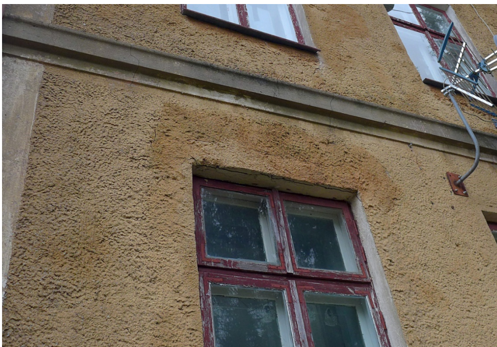
Fot. 10. Dębowiec 4, elewacja południowa, widoczne zawilgocenie muru nad oknem oraz warstwa zielonych nalotów biologicznych na gzymsie.
