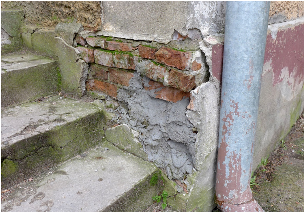
Fot. 11. Dębowiec 4, elewacja południowa, widoczne ubytki betonowej zaprawy cokołu w narożniku, częściowo zasmarowane cementem oraz porażenie biologiczne schodów i muru.
