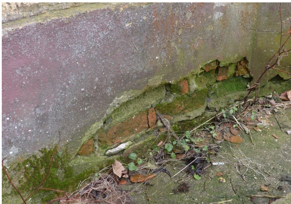
Fot. 16. Dębowiec 4, elewacja zachodnia, zbliżenie na cokół pokazuje silne zawilgocenie muru, cegły pokrywa warstwa mchów i porostów.
