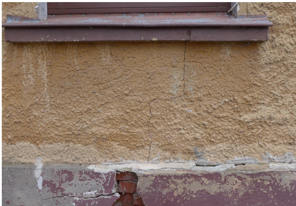
Fot. 14. Dębowiec 4, elewacja zachodnia, widoczne spękanie strukturalne wyprawy betonowej pod oknem parteru.
