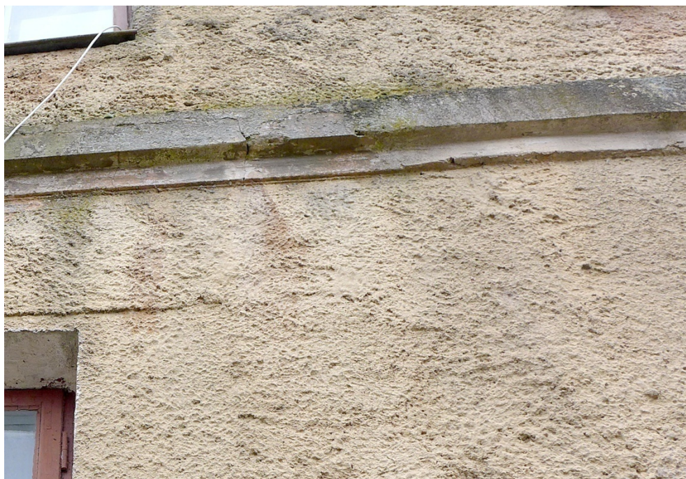
Fot. 4. Dębowiec 4, elewacja północna, zbliżenie na gzyms kordonowy pokazuje jego ugięcia i nieestetyczne opracowanie. Warstwa betonu spękana i pokryta mchami.
