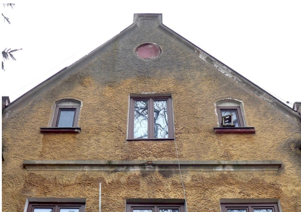
Fot. 22. Dębowiec 4, elewacja wschodnia, widok na szczyt, widoczne całkowicie wypłukane z farb zaprawy gzymsu i tła szczytu, widoczne też wstawione okna z nadprożem prostym w otwory z nadprożem w łuk odcinkowy.
