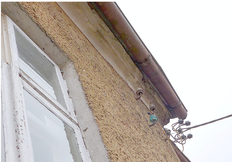
Fot. 1. Dębowiec 4, elewacja północna, widoczne ubytki gzymsu kordonowego oraz próba ich uzupełniania.
