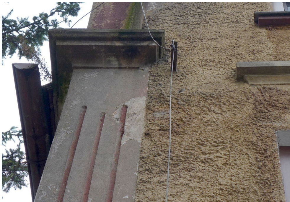
Fot. 21. Dębowiec 4, elewacja wschodnia, zbliżenie pokazuje dużą ilość wykwitów biologicznych ba gzymsie i narożniku oraz uzupełnienie pilastra.
