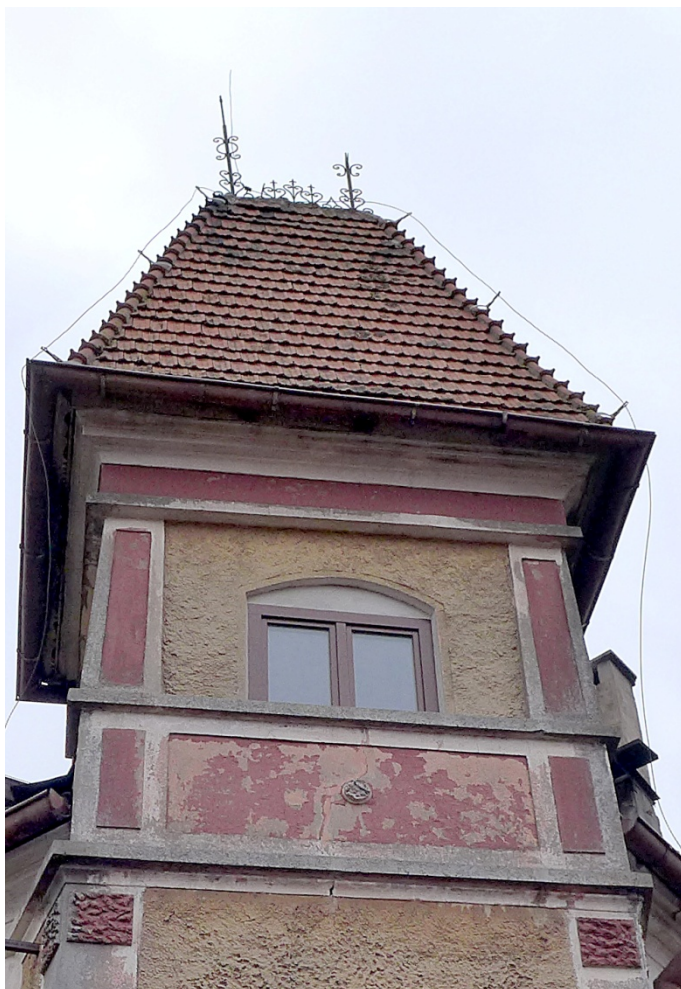
Fot. 17. Dębowiec 4, narożna wieżyczka, zbliżenie pokazuje fragmenty zachowanego detalu metaloplastycznego w kalenicy.
